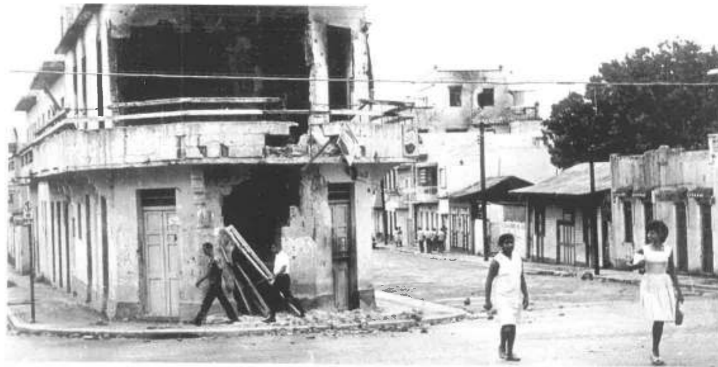
El nivel de destrucción que se observa en esta casa, evidencia el alto calibre de las armas que las tropas norteamericanas utilizaron masivamente en su ataque aereo de los días 15 y 16 de junio.
